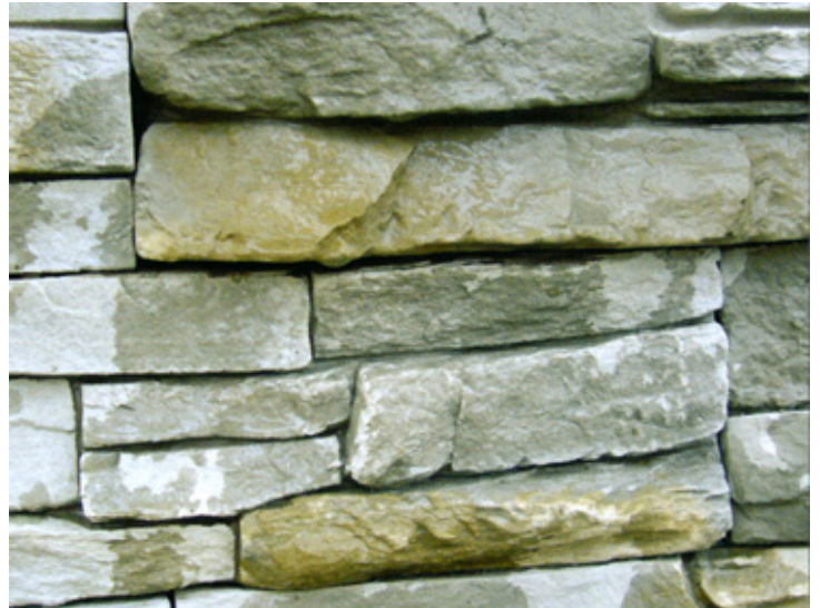
矽封劑 SE-2025 施工前
