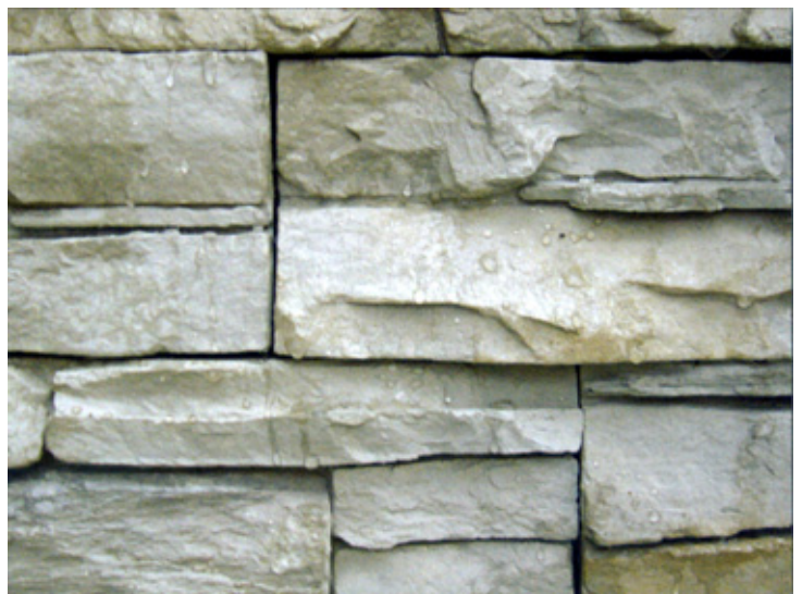
矽封劑 SE-2025 施工後
