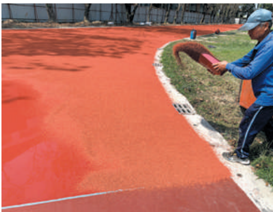
EPDM粒鋪設 Embedded EPDM
