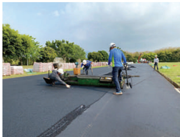
PU結合劑+NR粒施作 NR rubber with PU binder
