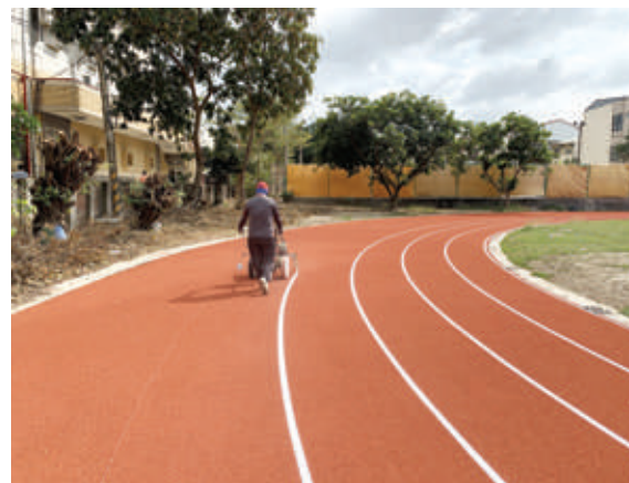
劃線 Line marking
