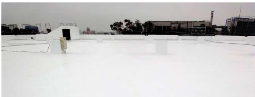
聚脲噴塗完成 / After application
