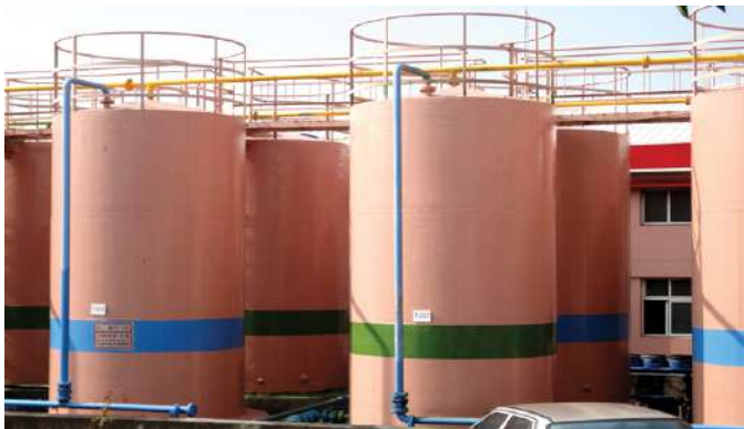
聚脲噴塗完成 / After application
