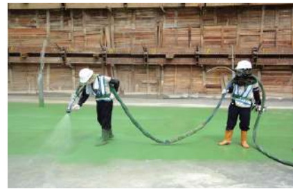
建築物大底防潮防水聚脲噴塗
