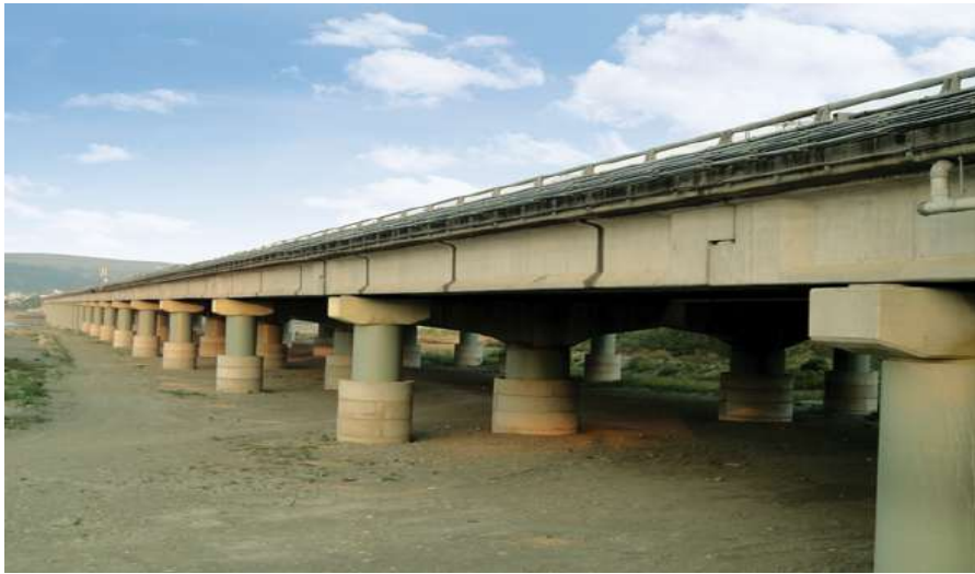
聚脲噴塗完成 / After application
