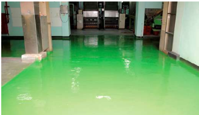
聚脲噴塗完成 / After application
