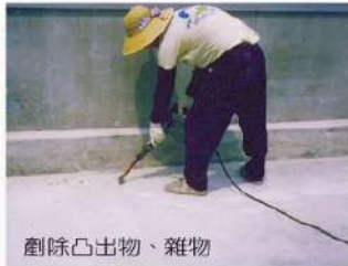
牆角補強施工
