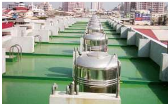
PU防水彩化屋頂工程 Waterproofing for roof
